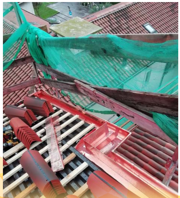
Un esempio del lavoro di adeguamento della latta alle irregolarità del tetto.
